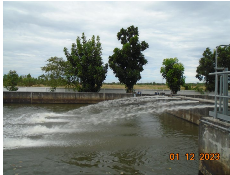
ภาพที่ 2-17 ระบบกระจายน้ำบริเวณจุดปล่อยน้ำลงสู่บ่อพักน้ำทิ้ง
