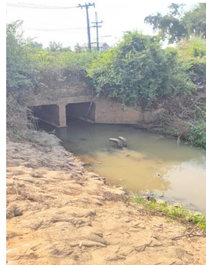
ภาพที่ 2-16 ระบบท่อระบายน้ำทิ้งจากโครงการไปยังคลองชุมพล (บริเวณฝายทดน้ำ)
